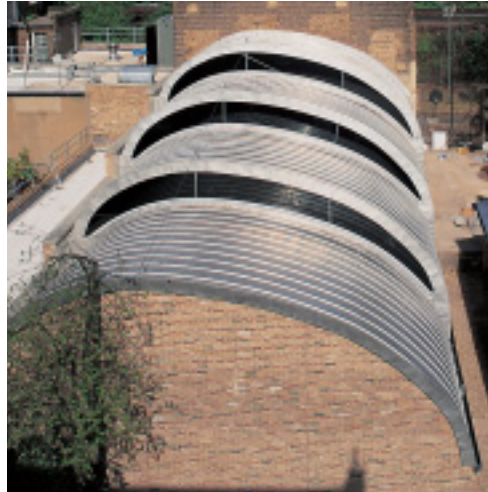
El acero inoxidable se utiliza para la cubierta externa de este tejado de formas inusuales.
